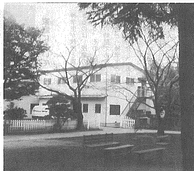
右は校庭から見た図書館 階下は折袴室
